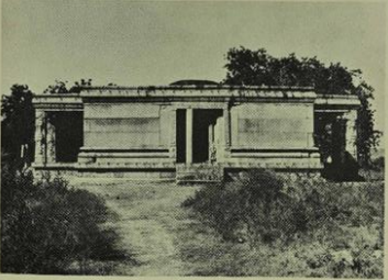
b. Façade Est.
